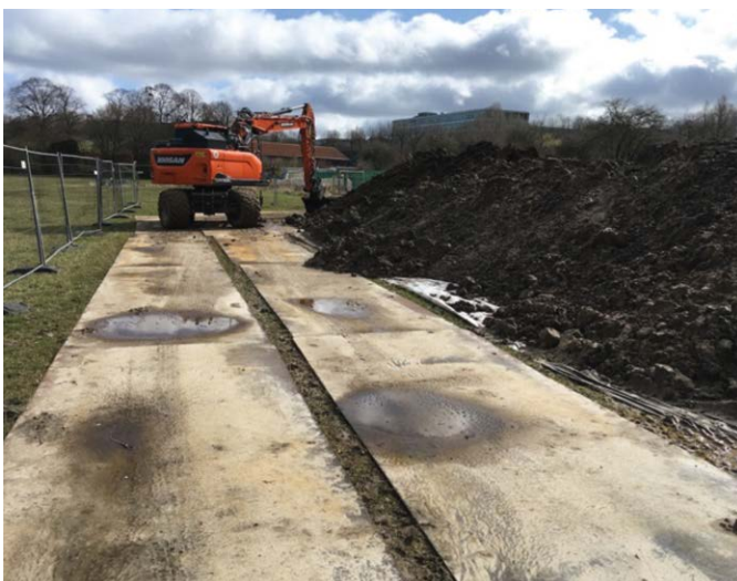
Abb. 4: Lastverteilungsplatten während (links) und Oberfläche nach Rückbau der Baustraße (rechts) bei einer Gewässerumbaumaßnahme (Bauzeit: 1,5 Monate) (ahu GmbH)
