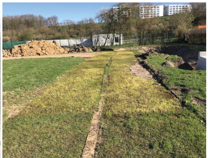
Abb. 4: Lastverteilungsplatten während (links) und Oberfläche nach Rückbau der Baustraße (rechts) bei einer Gewässerumbaumaßnahme (Bauzeit: 1,5 Monate) (ahu GmbH)
