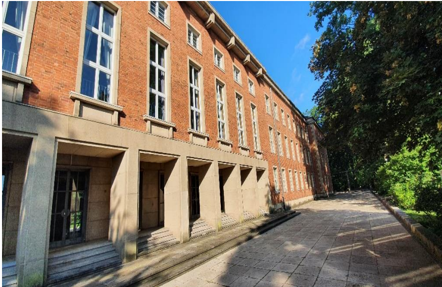
Abbildung 14: Außenansicht Niemannsweg 220 Quelle: LRH
