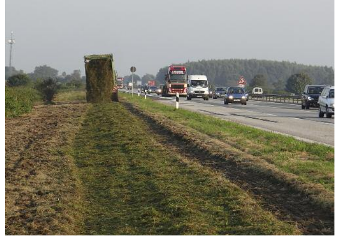
Abb. 3: Ausbringung des Mahdgut auf der Baustelle „Böschung Brekendorfer Moor“
