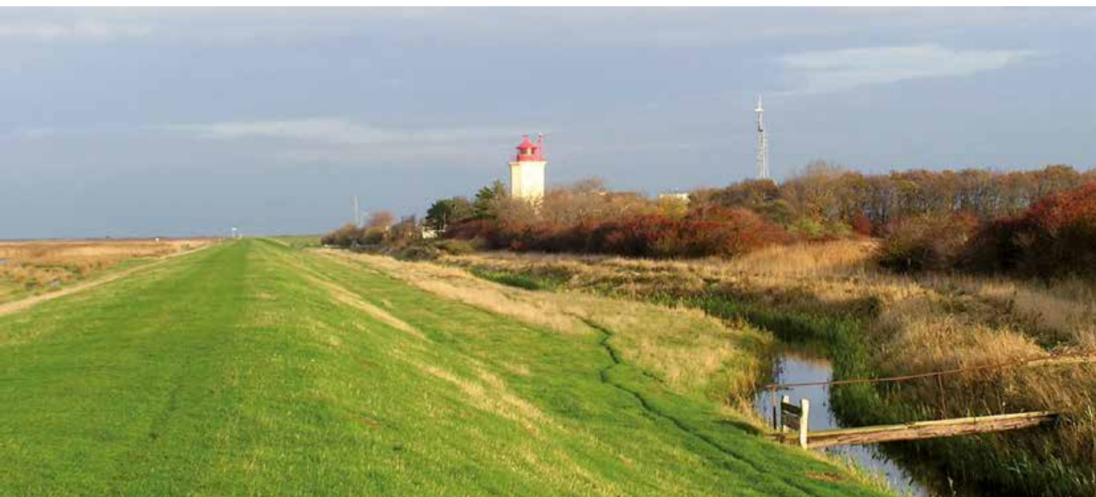
Abb. 1: Alter Deichabschnitt am Leuchtturm Westermarkelsdorf – ein internationaler Hotspot der Artenvielfalt
